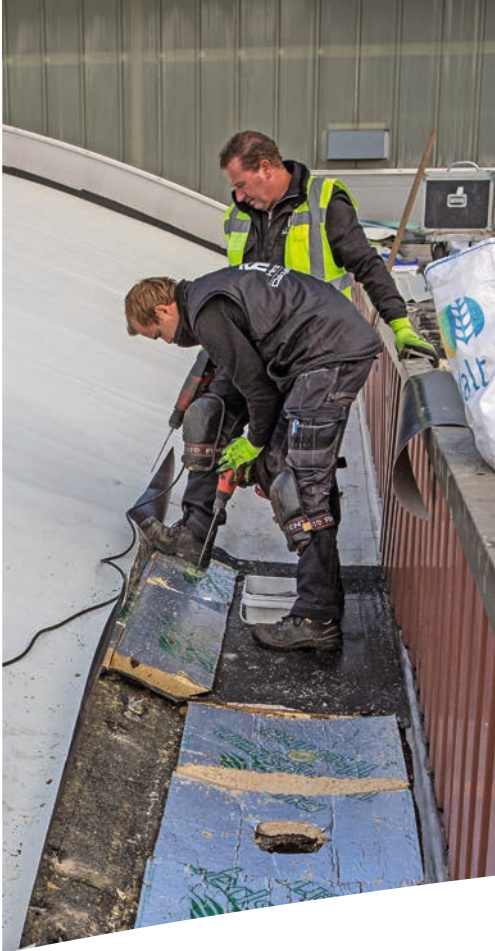
De dakdekkers werken vanuit de top van de boog terug naar beneden.
