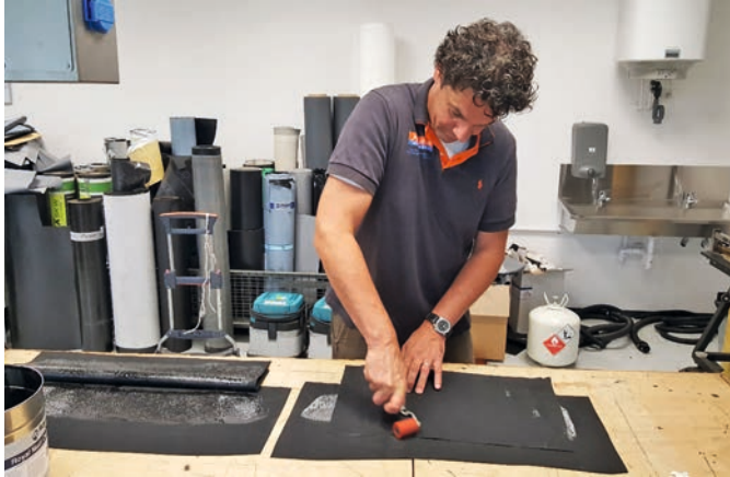
EPDM-training bij Royal. Lijmen kun je verwerken bij een oppervlaktetemperatuur van 5 graden Celsius en hoger.
