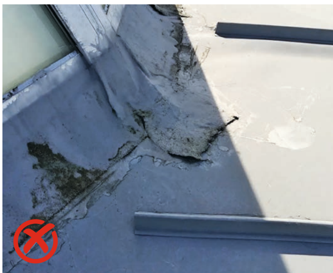
Bij toepassing van vloeibare afdichting is een juiste verwerking wel essentieel.
