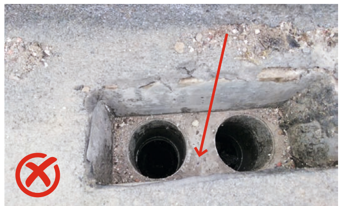
Dit is een tweeluikje: De HWA is hier niet waterdicht afgewerkt, het beton is namelijk nog te zien. En aan de rand boven de HWA laat het bitumen los.
