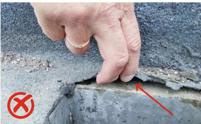
Dit is een tweeluikje: De HWA is hier niet waterdicht afgewerkt, het beton is namelijk nog te zien. En aan de rand boven de HWA laat het bitumen los.
