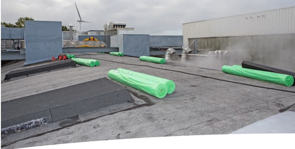
Aluminium gewapende bitumen doet dienst als waterkerende noodlaag en dampdichte laag voor het nieuwe dak.
