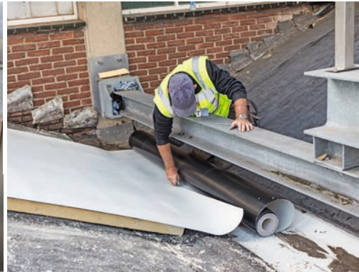
Aluminium gewapende bitumen doet dienst als waterkerende noodlaag en dampdichte laag voor het nieuwe dak.
