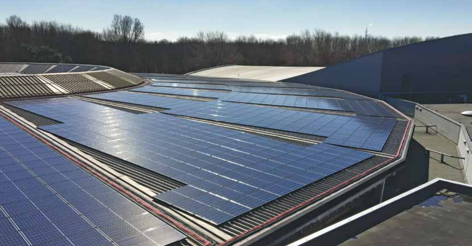
Renovatie Schaatshal de Uithof
