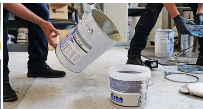
Alsan Flashing Jardin is een kant-en-klaar mengsel, voor het inwerken van details.
