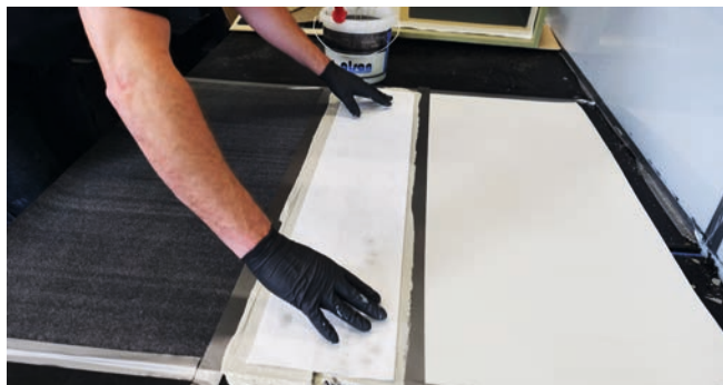
Met Alsan 770TX kun je ook aansluitingen tussen twee verschillende dakbedekkingen maken.
