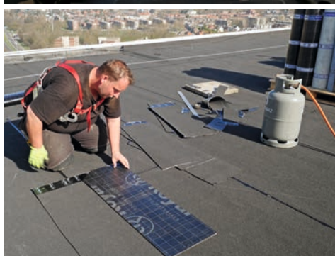
Het dak wordt gerenoveerd met bitumen, dat tweelaags wordt aangebracht.
