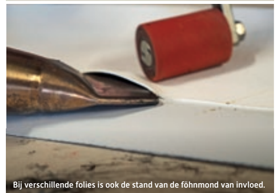
Een proeflas wordt zeker aanbevolen. Soms zelfs meerdere keren per dag.
