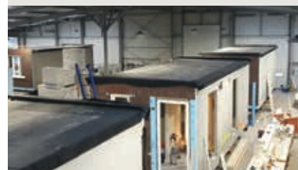
Stap 5: Dakbedekking aangebracht
