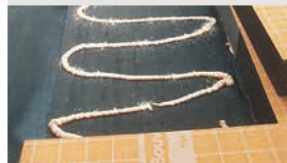
Stap 4: Aanbrengen dakisolatie
