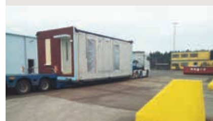
Stap 7: Transport naar bouwplaats
