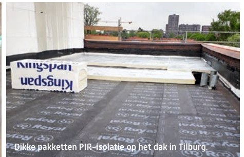
Dakdekker Martin Brekelmans moest een Rc van 9,0 realiseren
