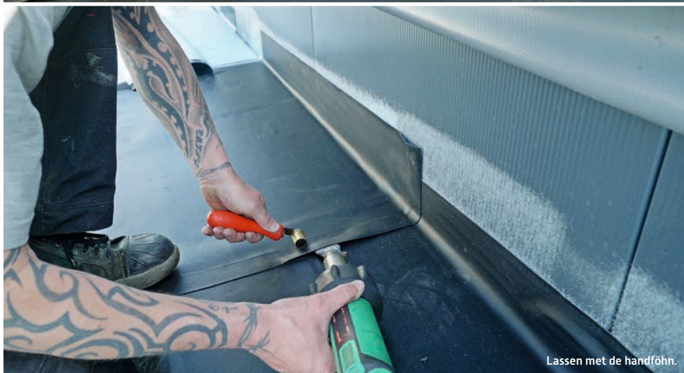
Overlappen aan elkaar lassen met een hetelucht-lasapparaat.
