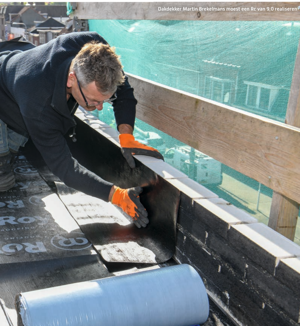
Dikke pakketten PIR-isolatie op het dak in Tilburg.
