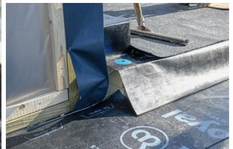
Door de vacuümpanelen kunnen de balkondeuren straks open. Het verschil met het isolatiepakket voor de rest van het dak is hier te zien.
