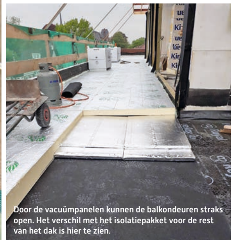
Dikke pakketten PIR-isolatie op het dak in Tilburg.
