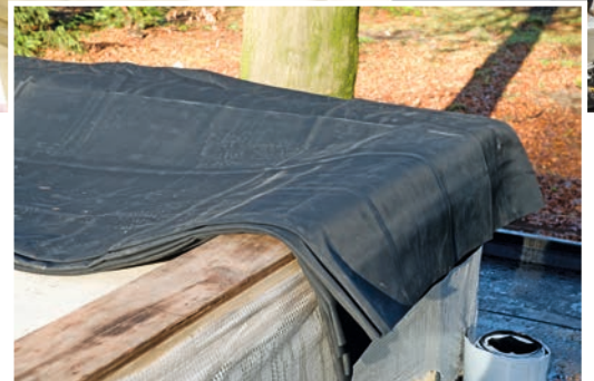
Uitrollen van een EPDM membraam. Laten rusten is belangrijk.
