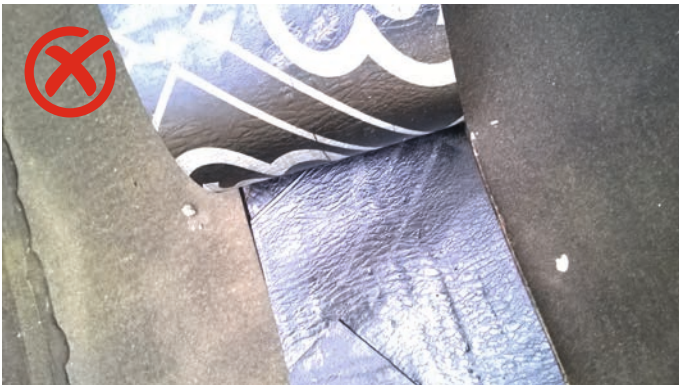
Bij tweelaags bitumen daksystemen moet de toplaag wel volledig gebrand of gekleefd zijn op de onderlaag.
