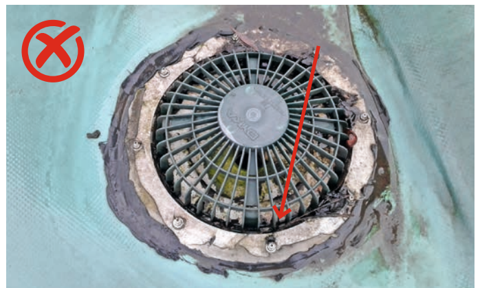
Waterdichte aansluitingen van onderdrukssystemen met PVC dakbedekking maken, lukt nooit met een kit rups.
