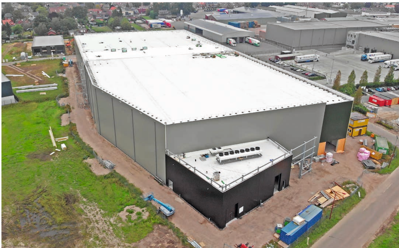
Voor het complete dak is 3.000 kilo lijm gebruikt.
