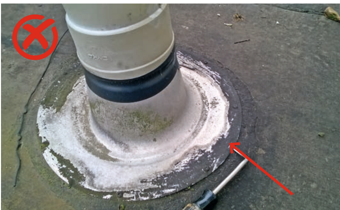
Plakplaten moet je echt inplakken met een manchet en niet alleen kit eronder.
