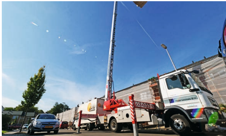
Veel verschillende werkzaamheden maken het werk complex.
