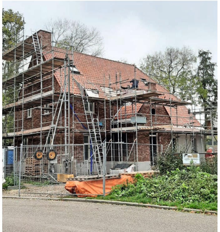
De bouw van de woning duurde 2 jaar.
