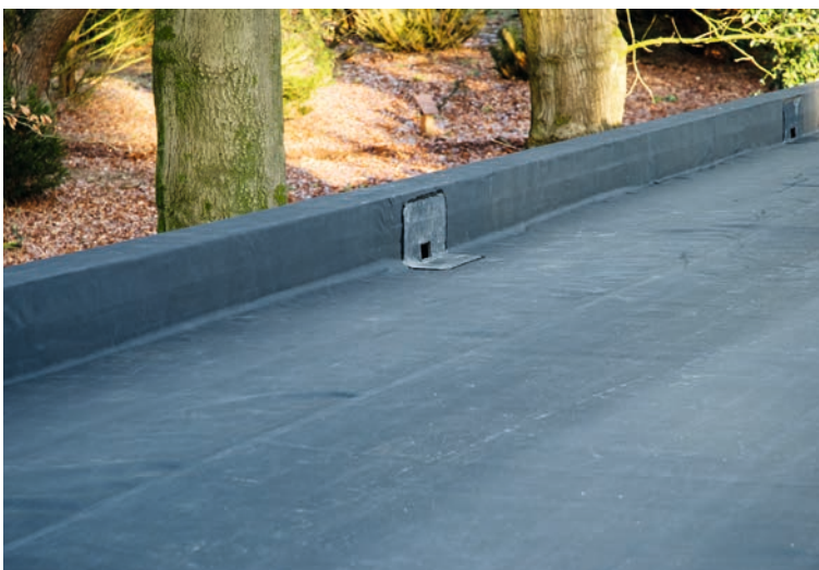
Mooi uitgevoerd EPDM dak.
