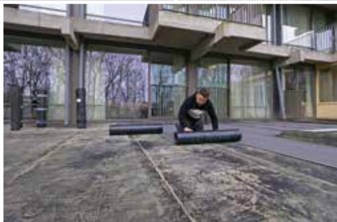
Het dak van de bredere eerste verdieping is overlaagd met Royalgum WW, een wortelwerende bitumen.
