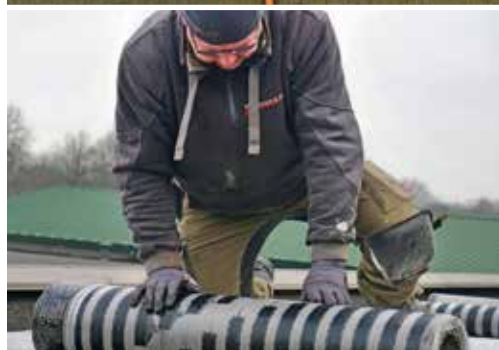
Royalgum Fusion is een echte 'renovatie-rol', vanwege de thermabanen aan de onderzijde, die zorgen voor een goede drukverdeling.
